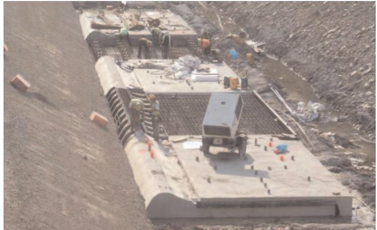
Fig. 15. Construcción del plinto en la presa de Terroba, incluida por Lafuente et al. en la R27.
